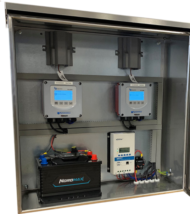
LEAKCELL LC221 med två ultraljudsflödesmätare, mobil-sändare, batteri och laddningsregulator till solpanel.
