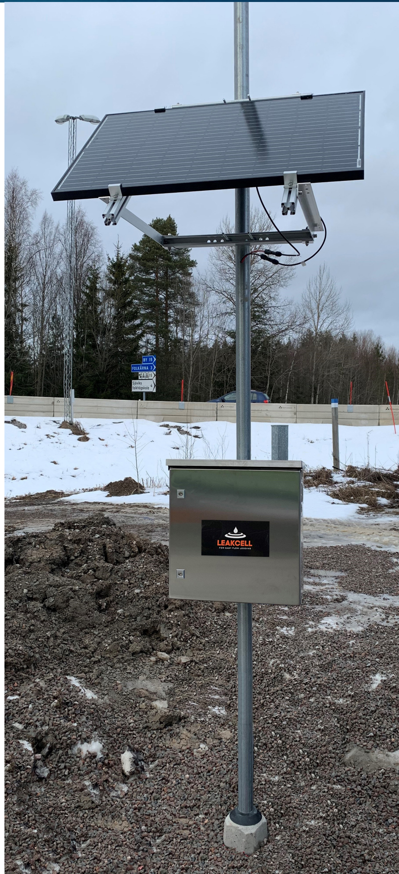
GSM router för koppling till driftkontrollsystem
